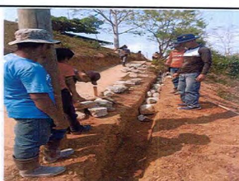
Foto 4: se observa el proceso de construcción del cemento del cerco en la parte de enfrente del establecimiento.
