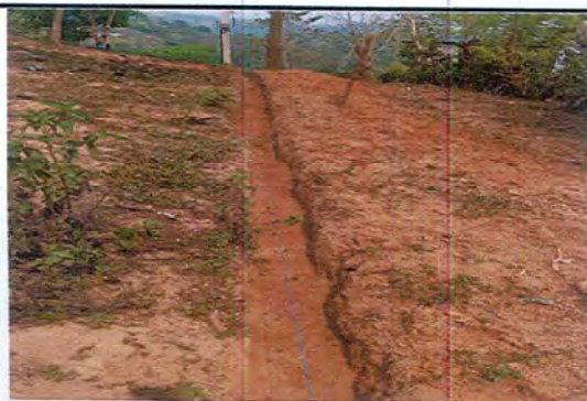
Foto 3: se observa el zanjeo para la construcción del cerco en la parte del riesgo de una pendiente cerca de la escuela.
