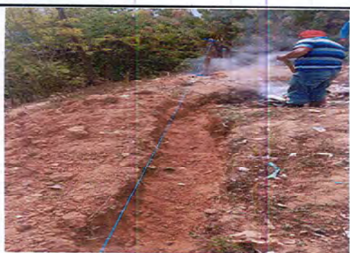
Foto 5: se observa el zanjeo para el cemento de la malla de circulación en la parte de atrás del establecimiento.
