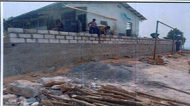
Foto 1: se observa el momento en que se construye el muro de soporte del establecimiento.
